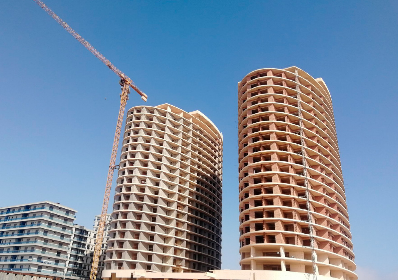
Edifício Millennium City - Lot 09
