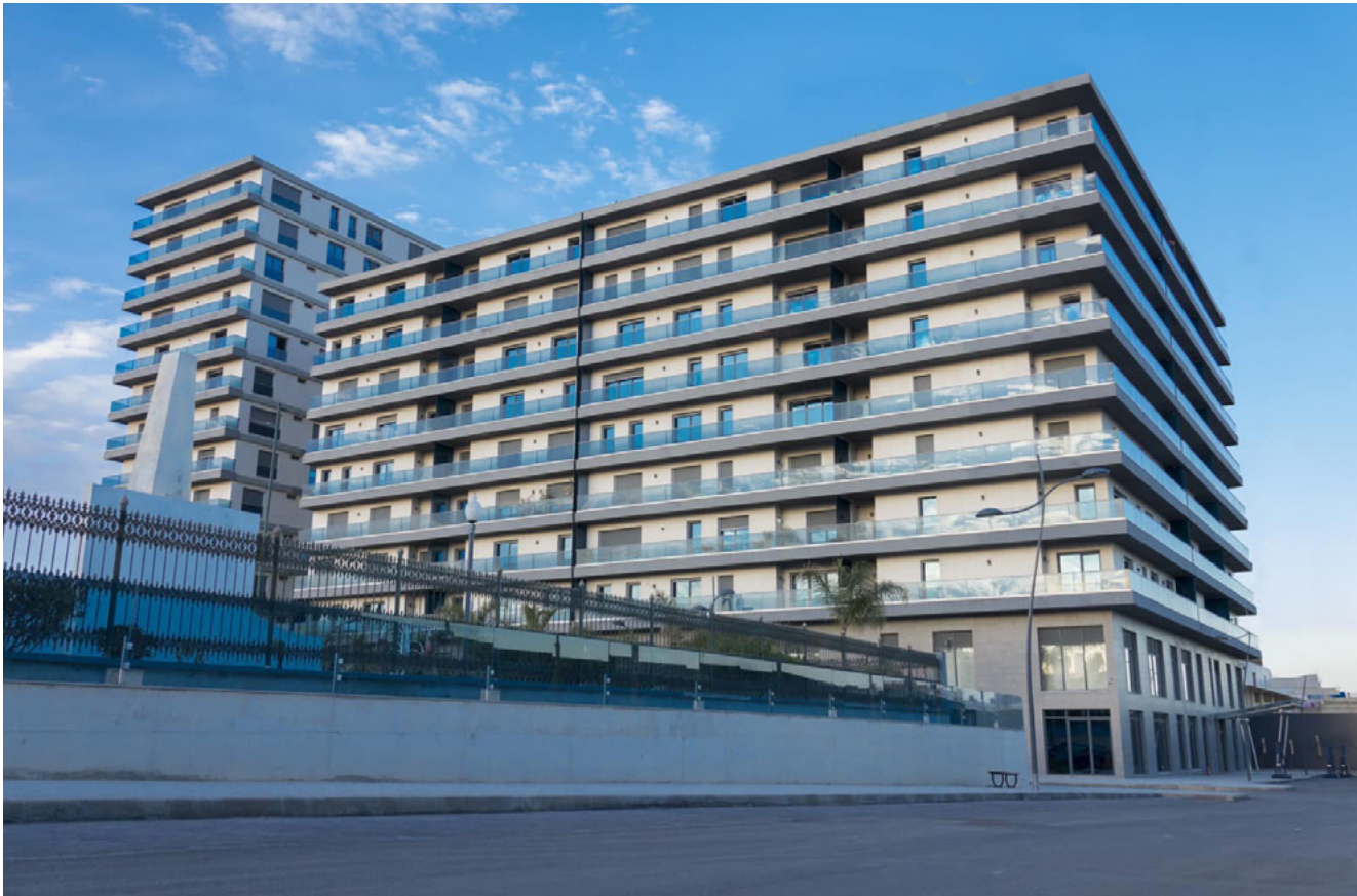
Edifício Millennium City - Lot 08
